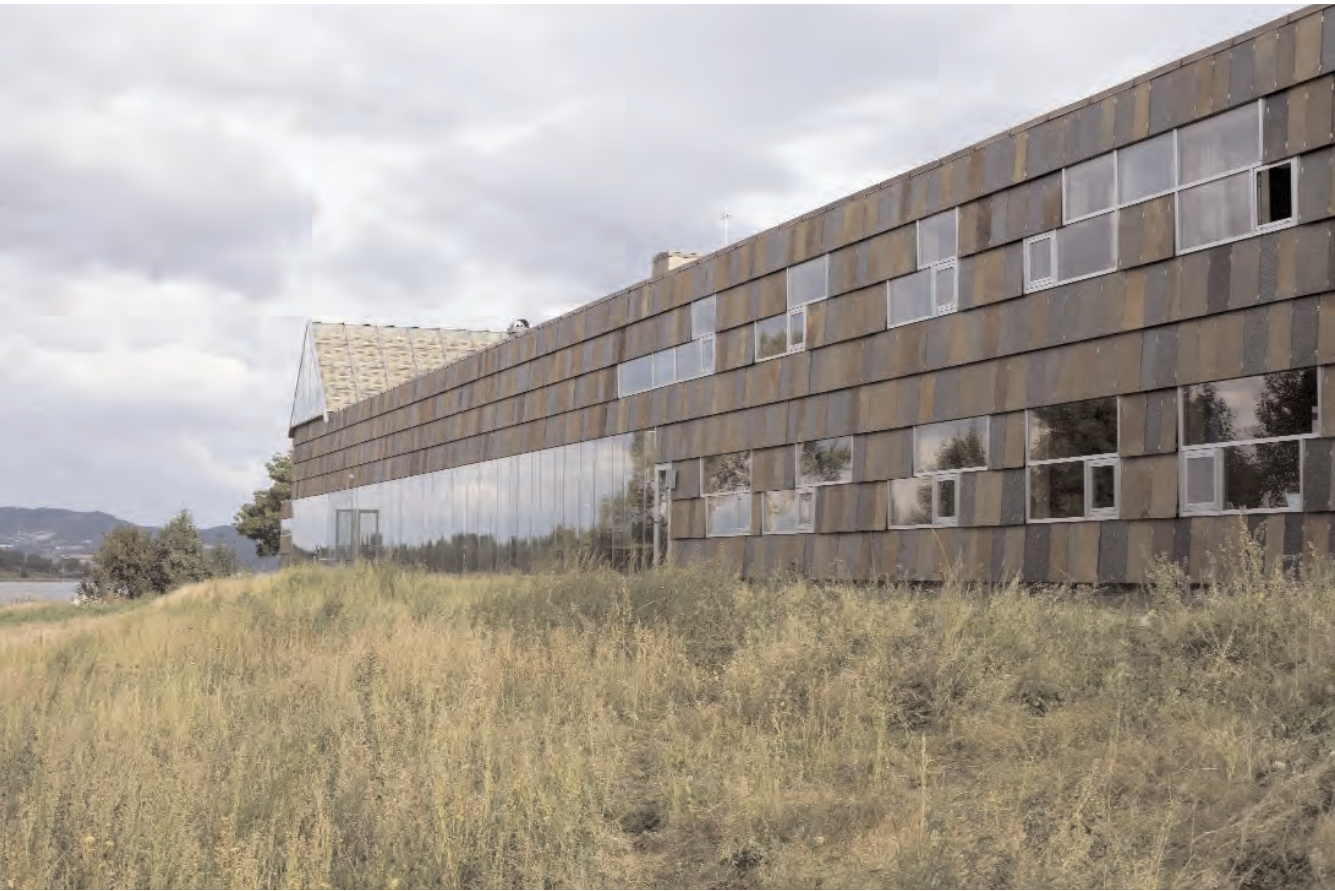
Vista esterna / External view
