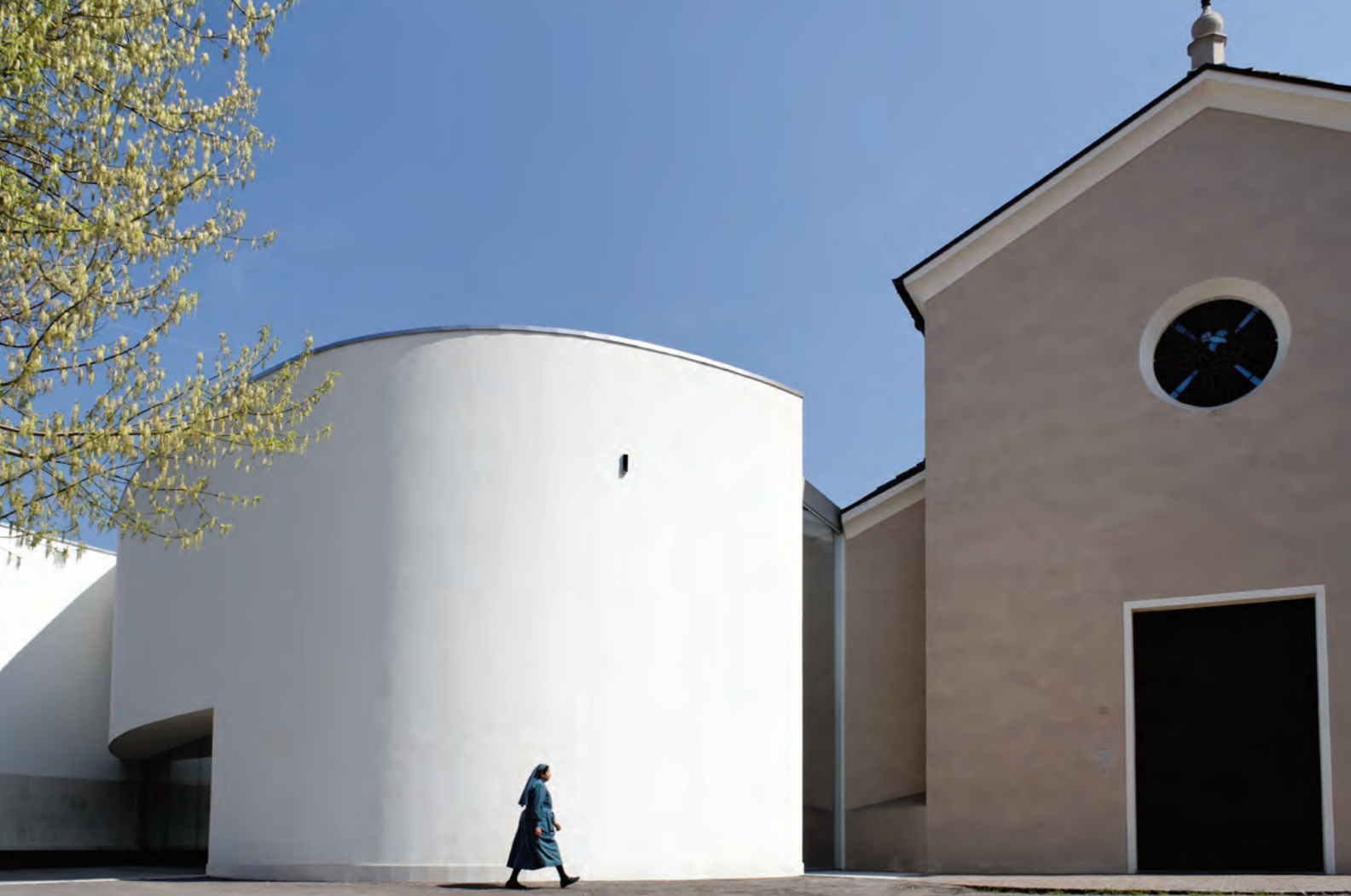
Il rapporto con la chiesa esistente / Rapport with the existing church
