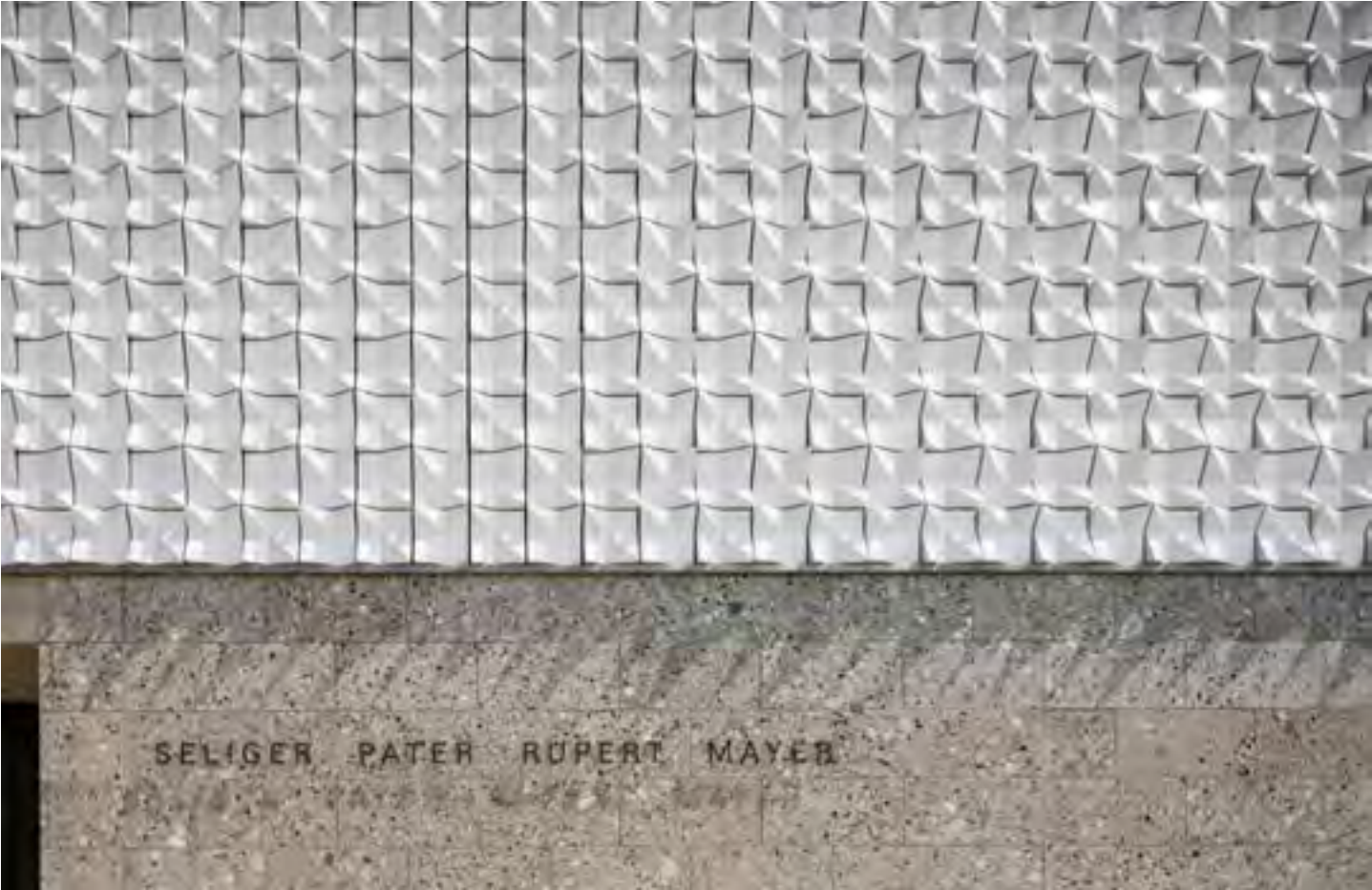
Vista dei rivestimenti esterni / View of the external cladding
