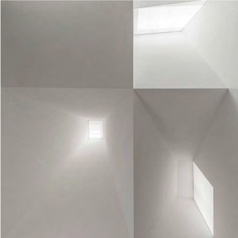
Particolare del soffitto / Detail of the ceiling
